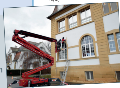
JANVIER : Changement des fenêtres du pavillon 27 accompagné par les services techniques
